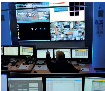
Blick in die neue Alarmempfangsstelle (AES)
